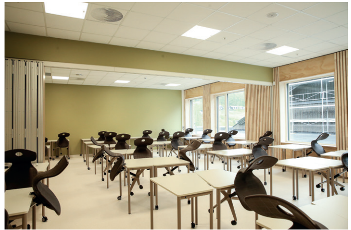
Klasserommene har vinylbelegg på gulv, gips på vegger med innslag av trespiler, og systemhimling i tak.
